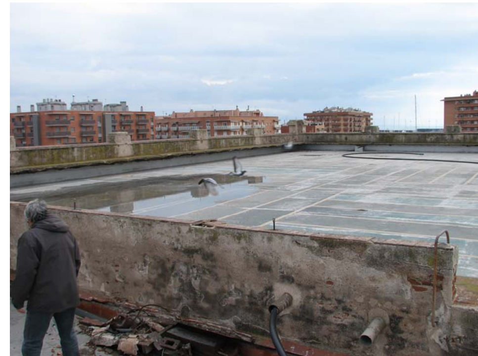
Vista de la coberta del magatzem
