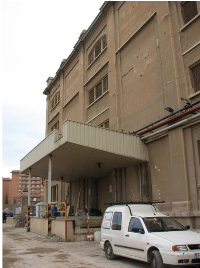
Vista de l'accés actual a la nau amb la marquesina metàl·lica que s'haurà de desmuntar.
