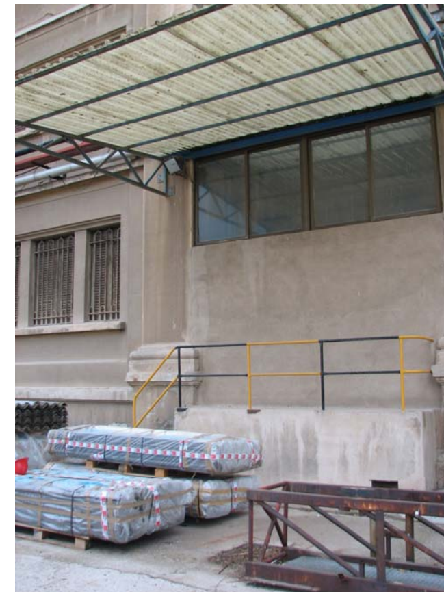
Vista de l'accés tapiat al nucli de comunicacions entre el magatzem 1 i 2.
