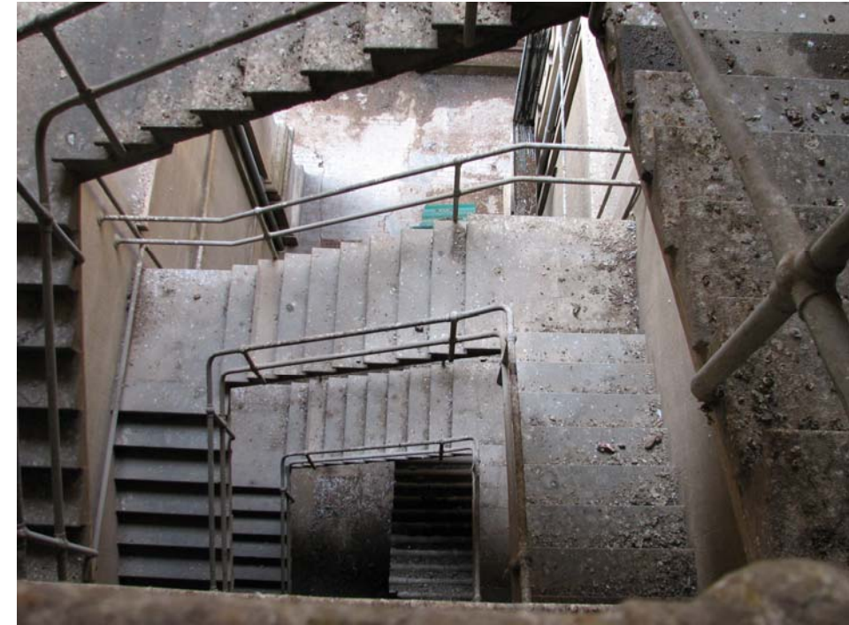
Vista de l'escala a substituir.
