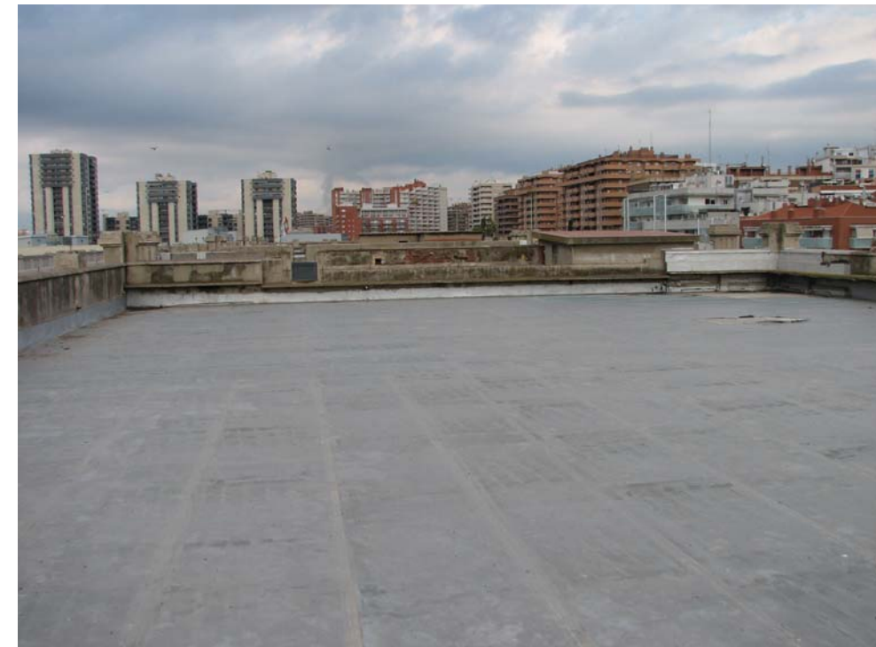
Vista de la coberta del magatzem.
