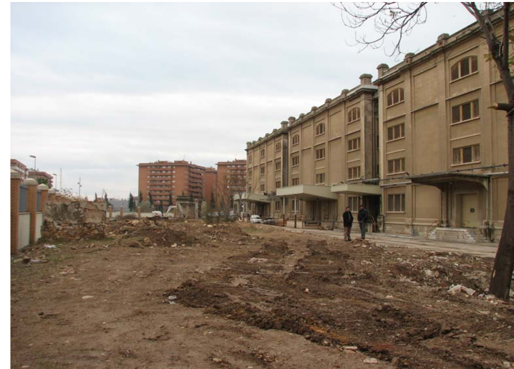
Vista exterior de la façana a l'Avinguda Vidal i Barraquer dels dos primers magatzems objecte de l'actuació.
